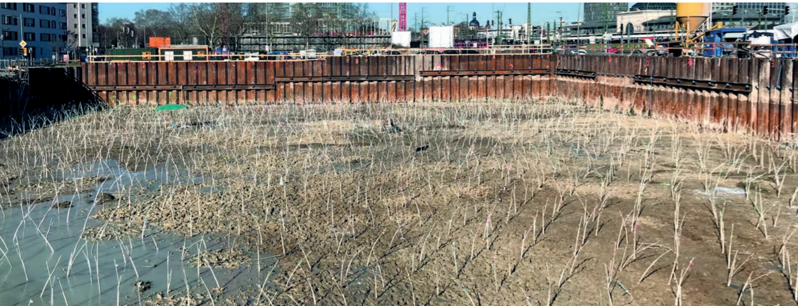
Weichgel-Injektionssohle als Dichtsohle mit geringem CO 2 -Footprint
