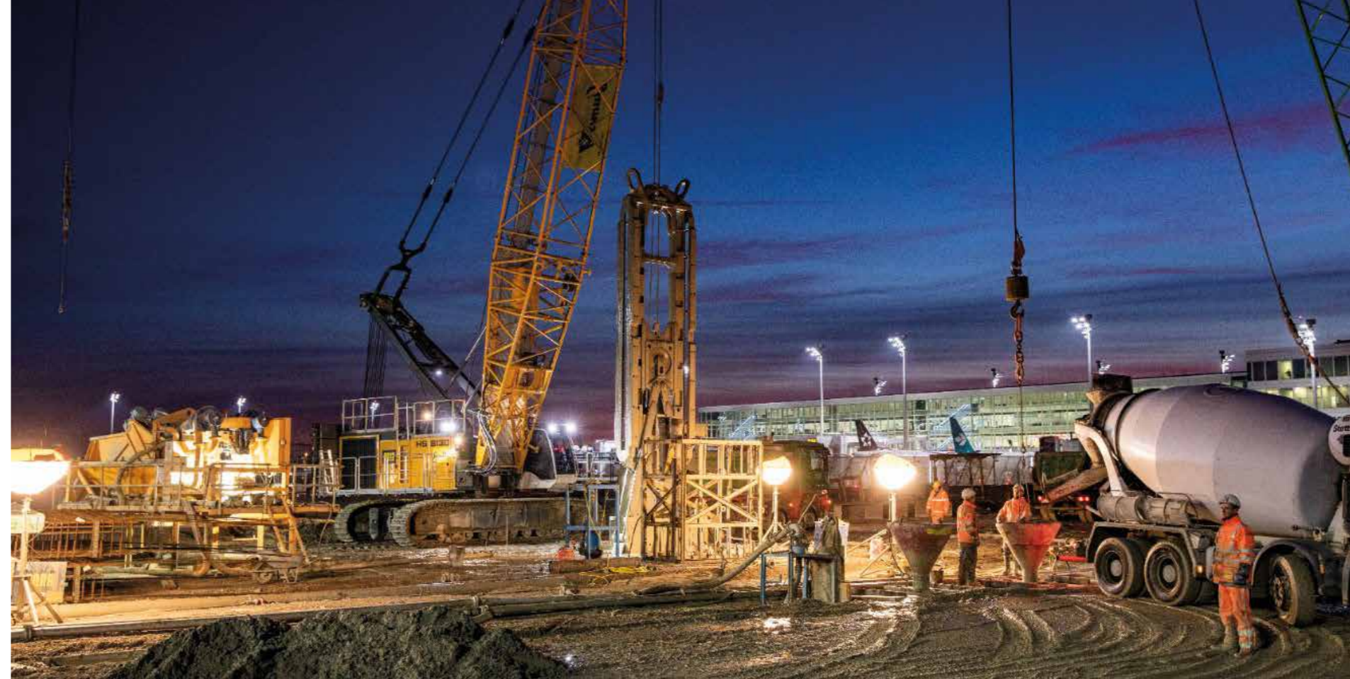
Flughafen München Erdinger Ringschluss, Schlitzwandarbeiten
